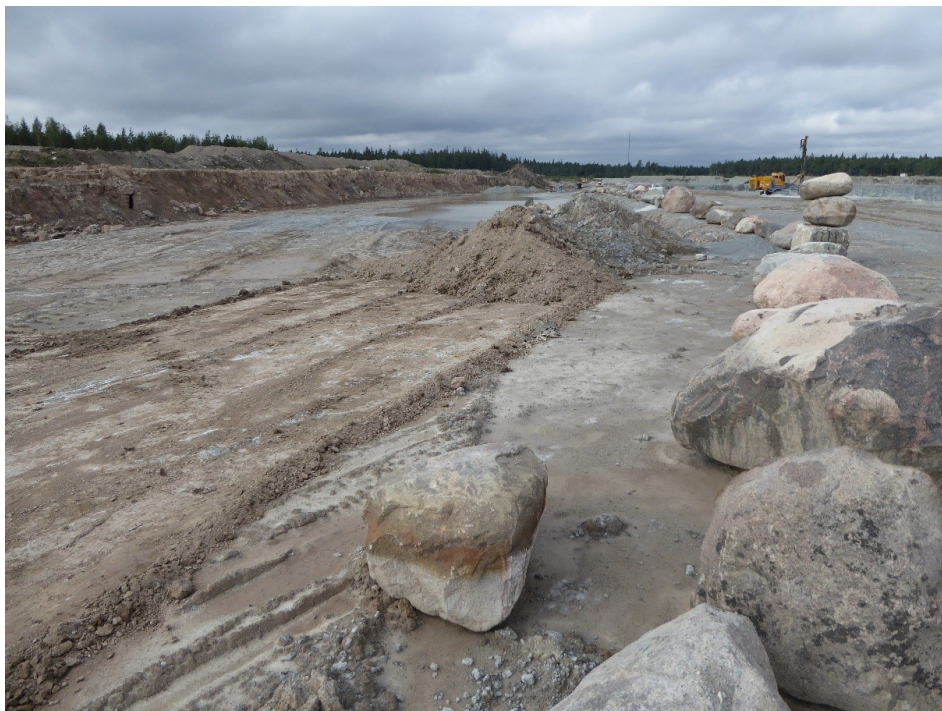
Figur 6.12. Det utökade täktområdet vid Västra brottet.
