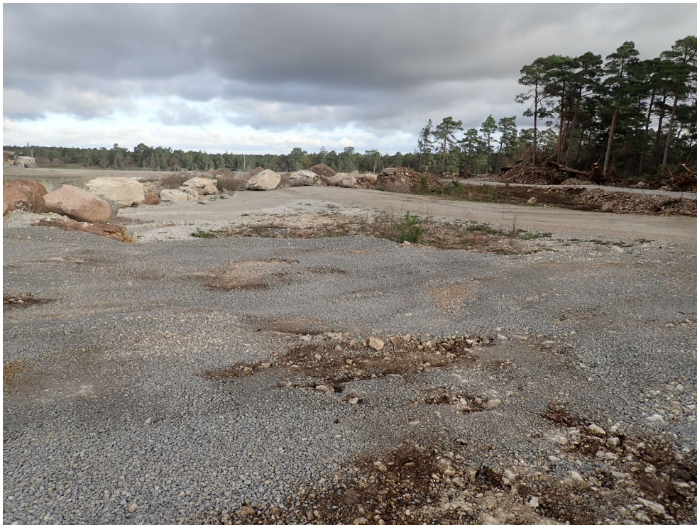
FIGUR 4 Nyligen avbanade ytor sydost om tälkten.
