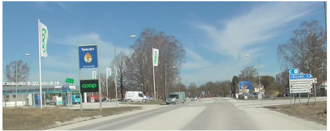
Väg 148 i Lärbro, strax väster om korsningen med väg 149.
