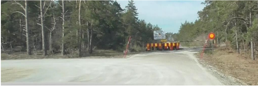
Avspärrning och rest av Väg 689 norrut från Väg 148.
