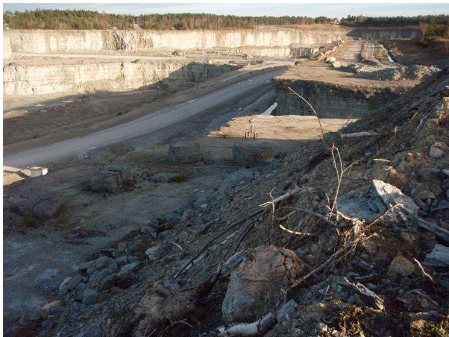
Figur 3: Foto från Västra deponin åt öster (taget innan deponin täcktes). I bilden syns deponeringsfickans öppning mot Västra brottet och den avbanade kalkstenshällen i kanten av brottet. Den kommunala deponin syns i bildens övre högra kant. De diken som avleder yttligt vatten från deponiområdena syns också i bilden
