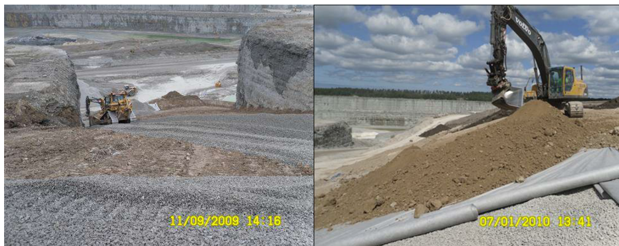
Figur 10: Avslutning Västra deponin: utläggning dräneringsgrus (vänstra bilden) samt geotextil och skyddstäckning (högra bilden).
