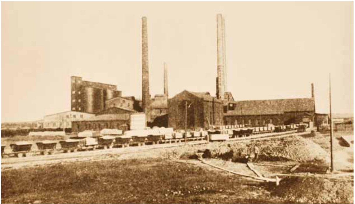
Klagshamnsfabriken på 1920-talet. Cementsilorna i bakgrunden göts i armerad betong och finns fortfarande kvar. Bild från Cementas arkiv, Landsarkivet Lund
