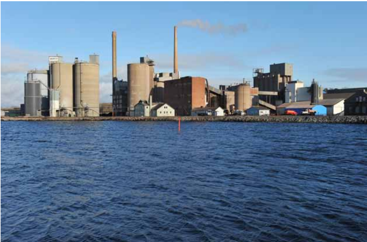
Cementfabriken i Degerhamn sedd från södra pirarmen i hamnen. Foto SOA 2010
