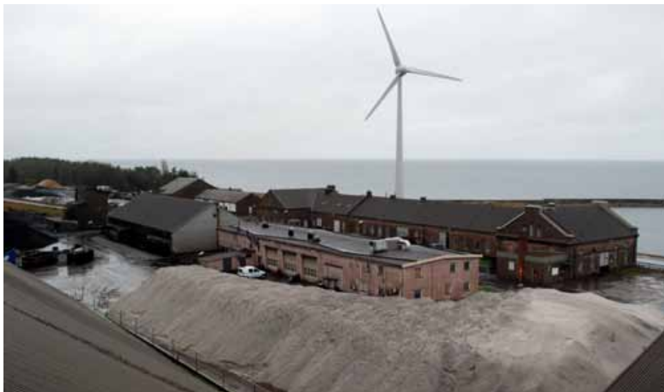
Bilden är tagen från stenlagrets övre del mot söder. Tekniskt kontor och fordonsverkstad finns i den rosa byggnaden och strax bakom denna syns en av fabriken's äldsta byggnader som inrymmer verkstäder och förråd. Den stora sandhögen i förgrunden utgör en av råvarorna i cementtillverkningen. Foto LKU 2010
