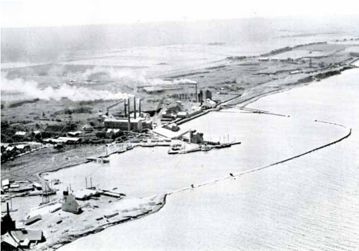
Flygfoto över Degerhamn från år 1934. Till vänster syns byggnaderna som tidigare tillhörde Degerhamns kalkbruk, i mitten cementfabriken med det nya packhuset nere vid den stora kajen. Söder om fabriken syns verkstadsbyggnaden, kraftcentralen och masugnsanläggningen. Bild ur Killig 1936
