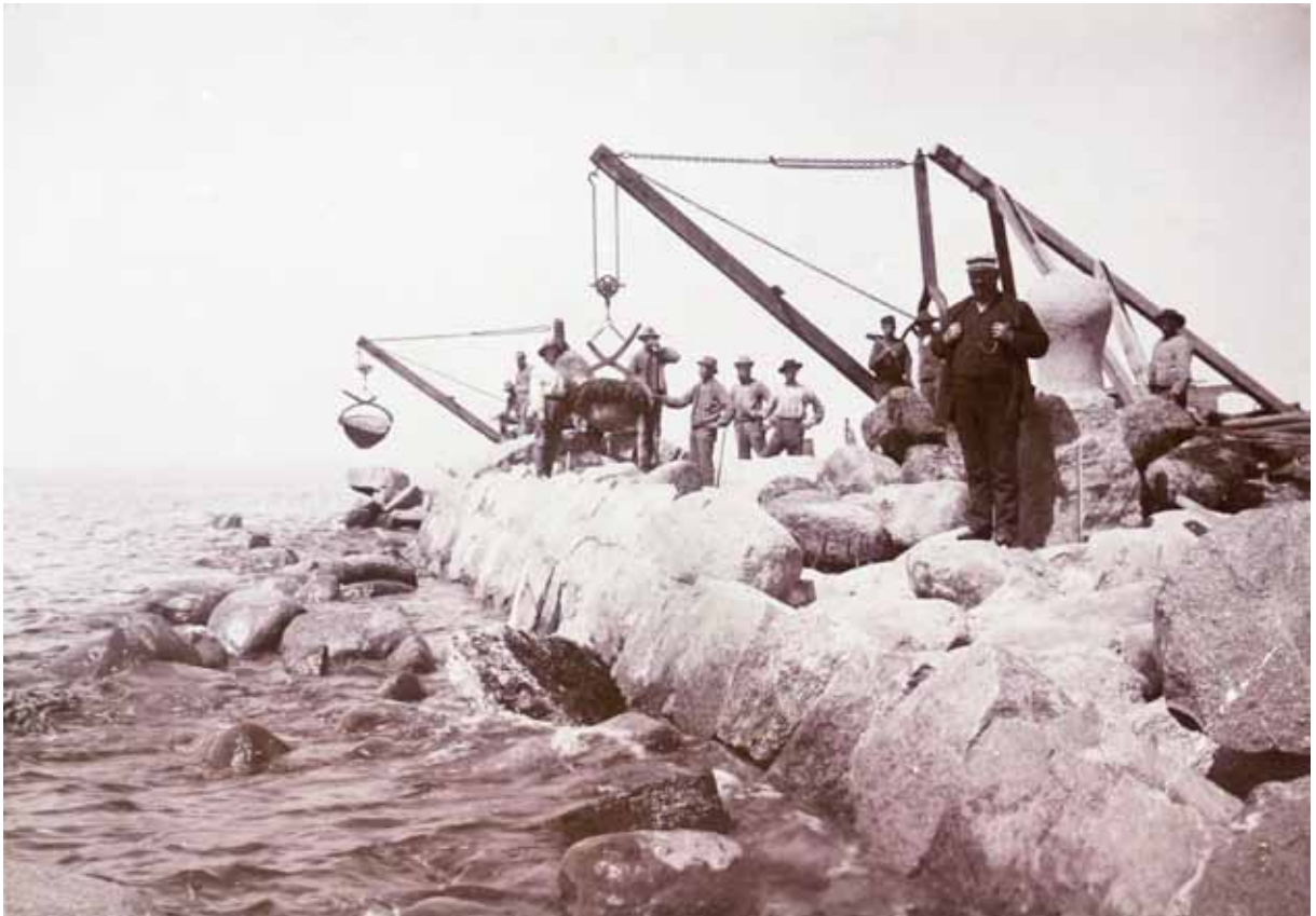
Handkraften dominerade vid många av arbetsuppgifterna i hamnen. Här har stenhuggarna stannat upp ett ögonblick för fotografen som fångat bygget av den nya piren. Bild från Cementas arkiv, Landsarkivet Lund
