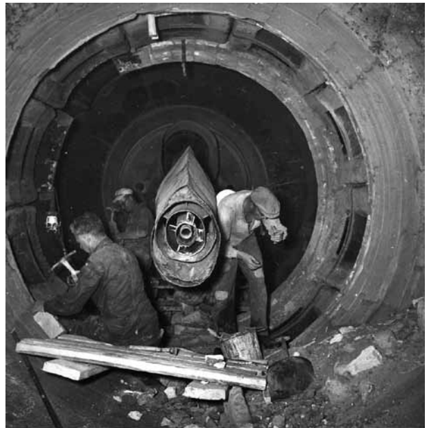
Kontrasten mellan den övergivna känslan som anläggningen utstrålar idag (bilden till vänster) och den svartvita bilden ovan är påfallande stor. Arbetarna kämpar med att mura om roterugnens infodring vid utloppshålen till klinkerkylarna. I mitten syns brännarlansen som är försedd med ett profilerat skydd för att förhindra klinkern från att fastna på översidan. Foto SOA 2009 och Bild- och Folkrorelsearkivet, Nynäshamn
