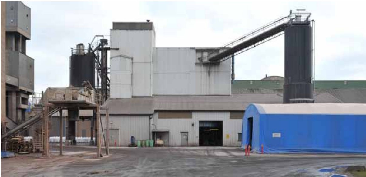
Agitatorverket eller microcementtillverkningen ligger i en separat byggnad inne på fabriksområdet. Anläggningen har en egen silo för byggcement från Slite som används som råvara till en av kvaliteterna. Foto SOA 2010
