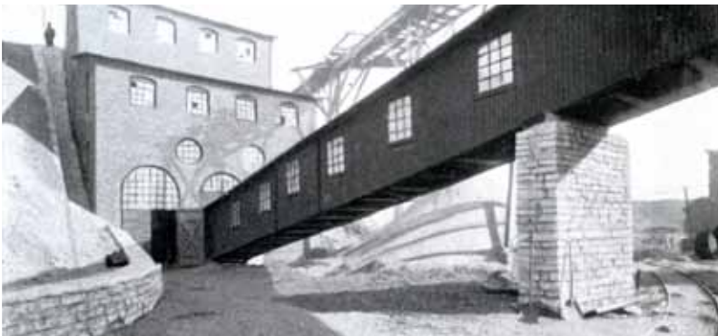
Vänster: Krosshuset på en bild från år 1918. Bandgången där den krossade skiffern matades ut leder till pannhuset. Bild ur Killig 1936
