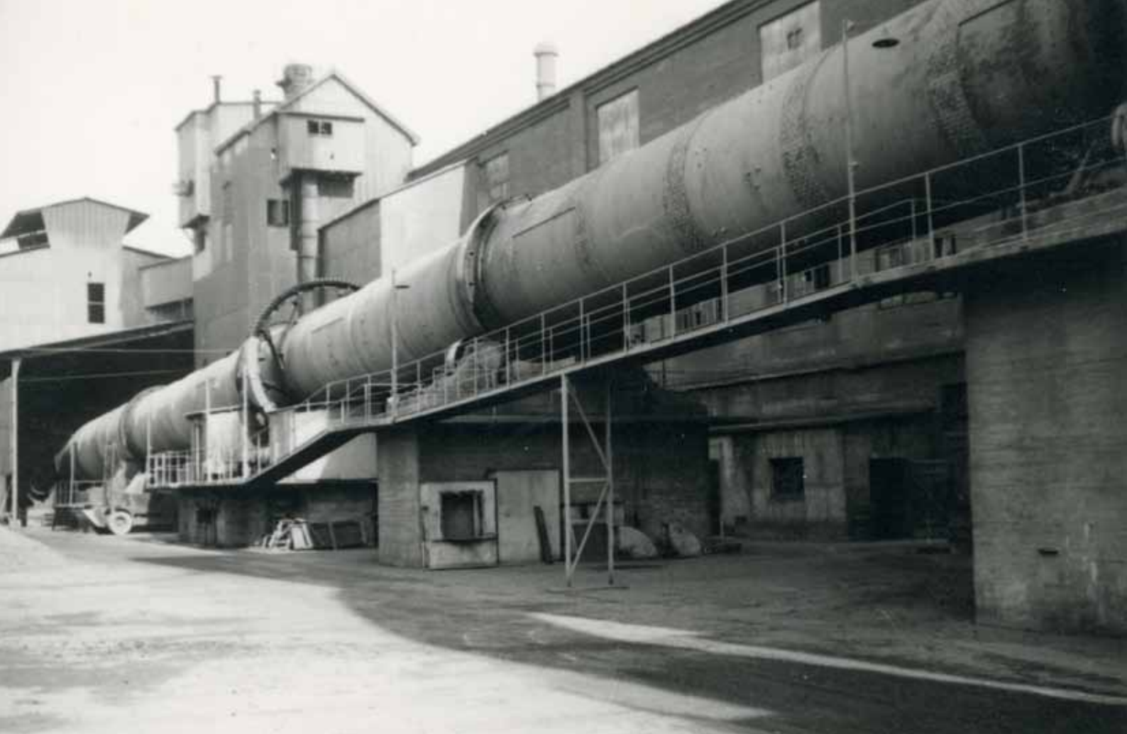
Ugn 3 på plats i fabriken framför den norra långsidan på roterugnshuset från år 1908. Bilden är sannolikt tagen i mitten av 1950-talet. Bild från Södra Möckleby Hembygdsgeningsförening
