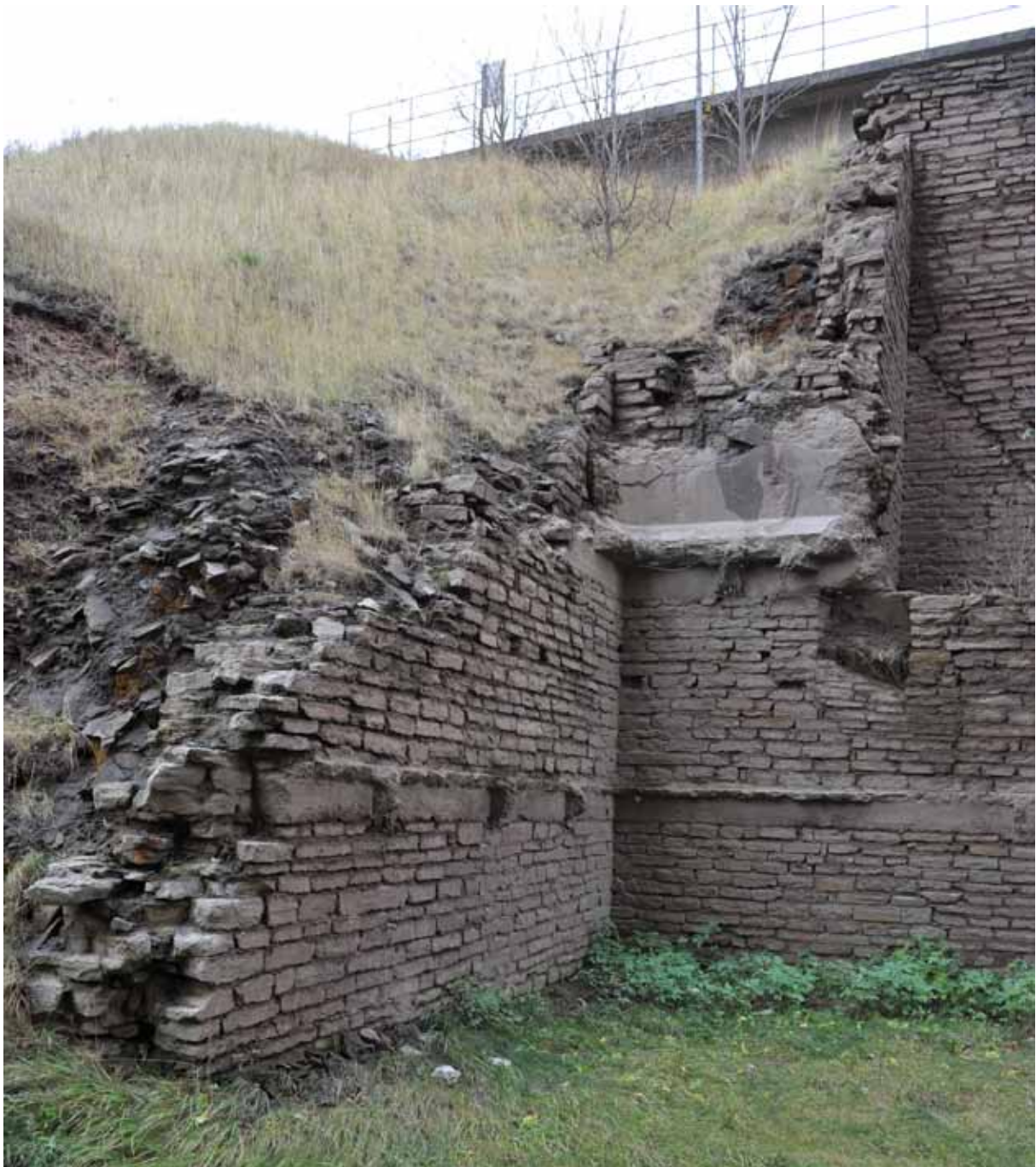
I slänten bakom klinkersilon finns grundresterna efter det kalkstenskrosshus som en gång betjänade den första cementfabriken. Bild SOA 2010
