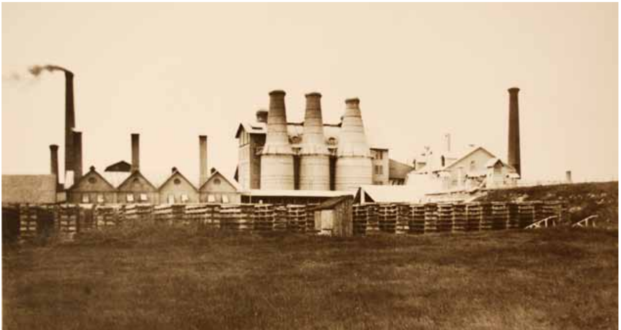
Sveriges första cementfabrik fotograferad år 1875, ett år efter produktionsstarten. I bildens mitt syns tre schaktugnar i vilka råvarorna brändes till klinker. I förgrunden finns torkställningar i det fria för de tegelformade råvarorna som senare matades in i ugnarna. Bild från Cementas arkiv, Landsarkivet Lund.
