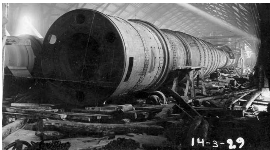
Installation av roterugn 2 medan produktionen pågår för fullt i den första ugnen bredvid. Bild från Slite Industrimuseum
