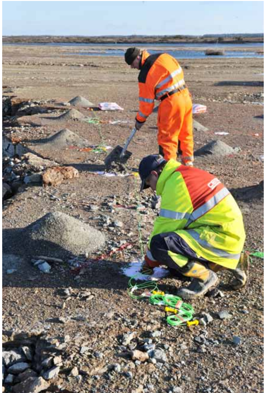
Överst: Gruvan är vidsträckt och omfattar flera kvadratkilometer. Sprängarbasen Paul Johansson med famnen full av elektriska detonatorer – som kopplas samman till ett noga uträknat nät där laddningen i varje borrhål kommer att detonera med en anings tidsförskjutning. Allt för att salvan ska släppa på ett kontrollerat sätt. Bild SOA 2010
