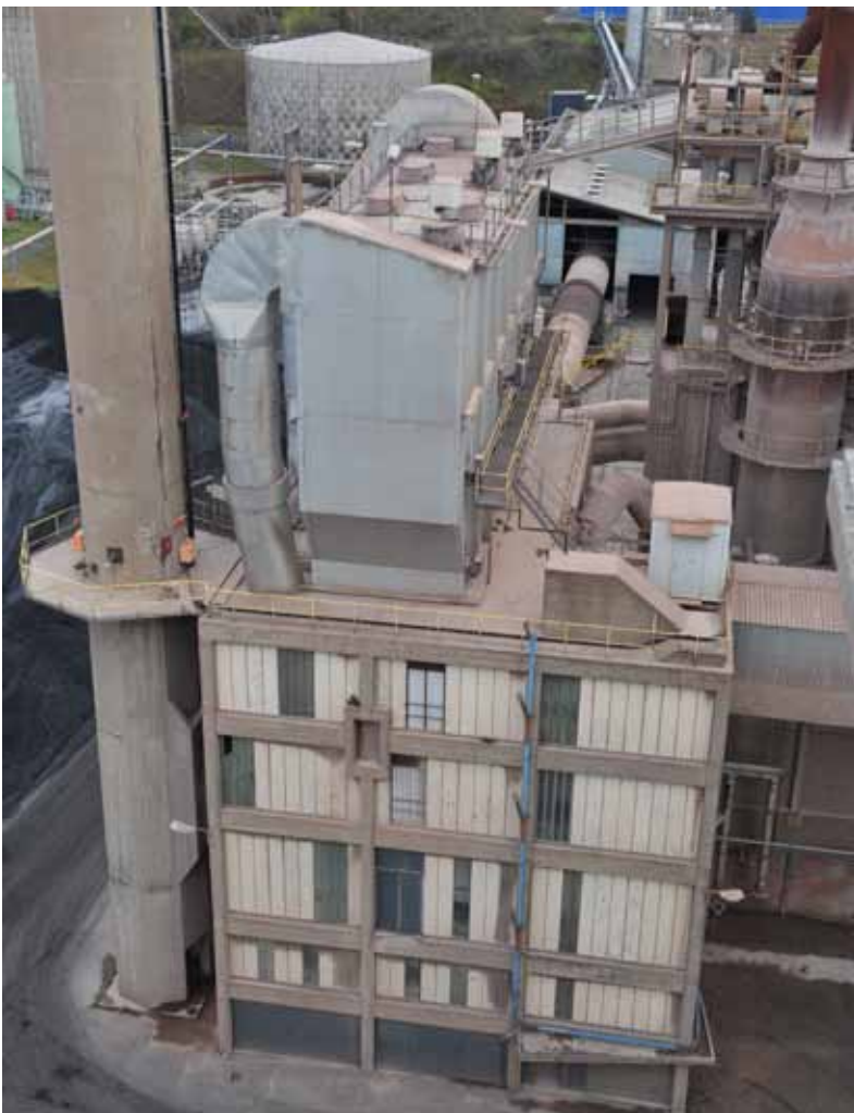
Elfiltret för ugn 4 sitter på toppen av ugnstornet och är en tämligen stor anläggning. Foto SOA 2010
