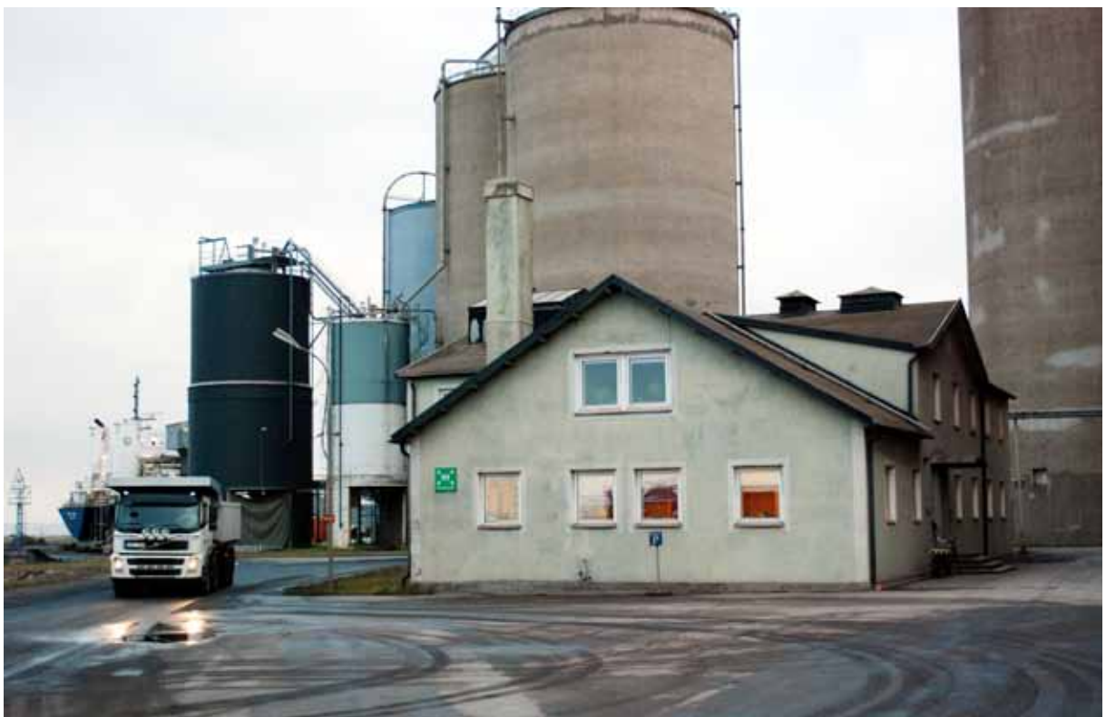
Kontorsbyggnaden ligger centralt inne på fabriksområdet nära hamnen. Foto LKU 2010
