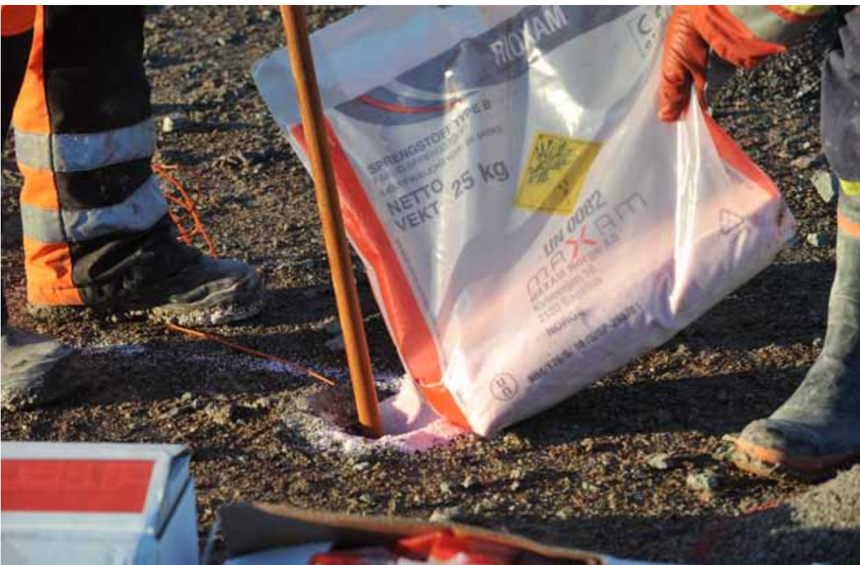
Sprängmedlet hälls i borrhålen i form av ett granulat. Avståndet till markytan kontrolleras med en laddkäpp så att förladdningen och pluggen får plats. Foto SOA 2010
