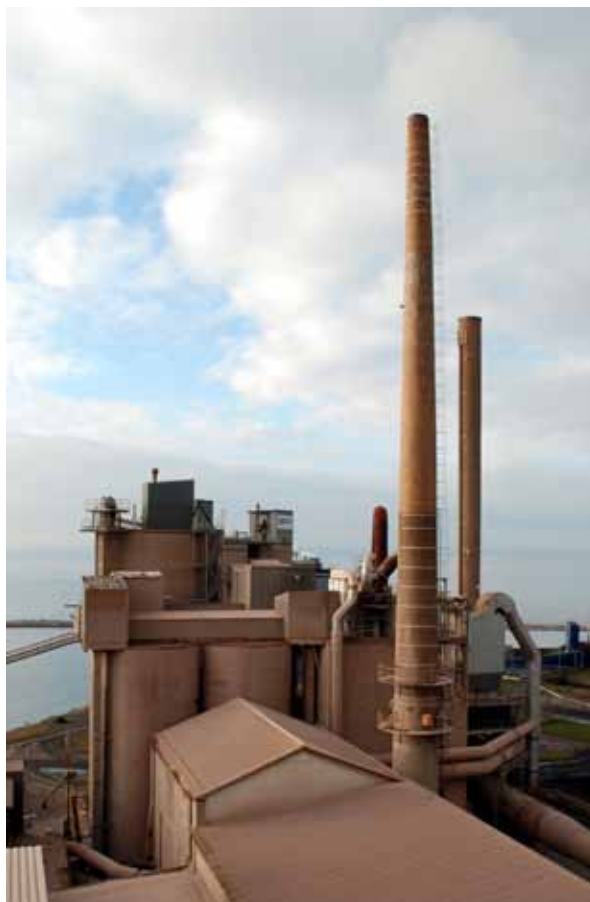
Anläggningen sedd från klinkerlagrets tak med ugn 4 längst ner i högra hörnet. Skorstenen i tegel närmast kameran uppfördes i samband med ugn 3 och betongskorstenen längre bak tillhör ugn 4. Foto LKU 2010
