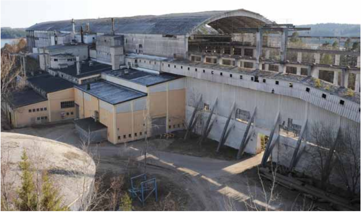
Råmateriallagret i Stora Vika börjar se allt mer skamfilat ut och delar av taket har fallit in.. Ännu kan en besökare dock ana den storhet som fanns i anläggningen då den var i full drift. Foto SOA 2009
