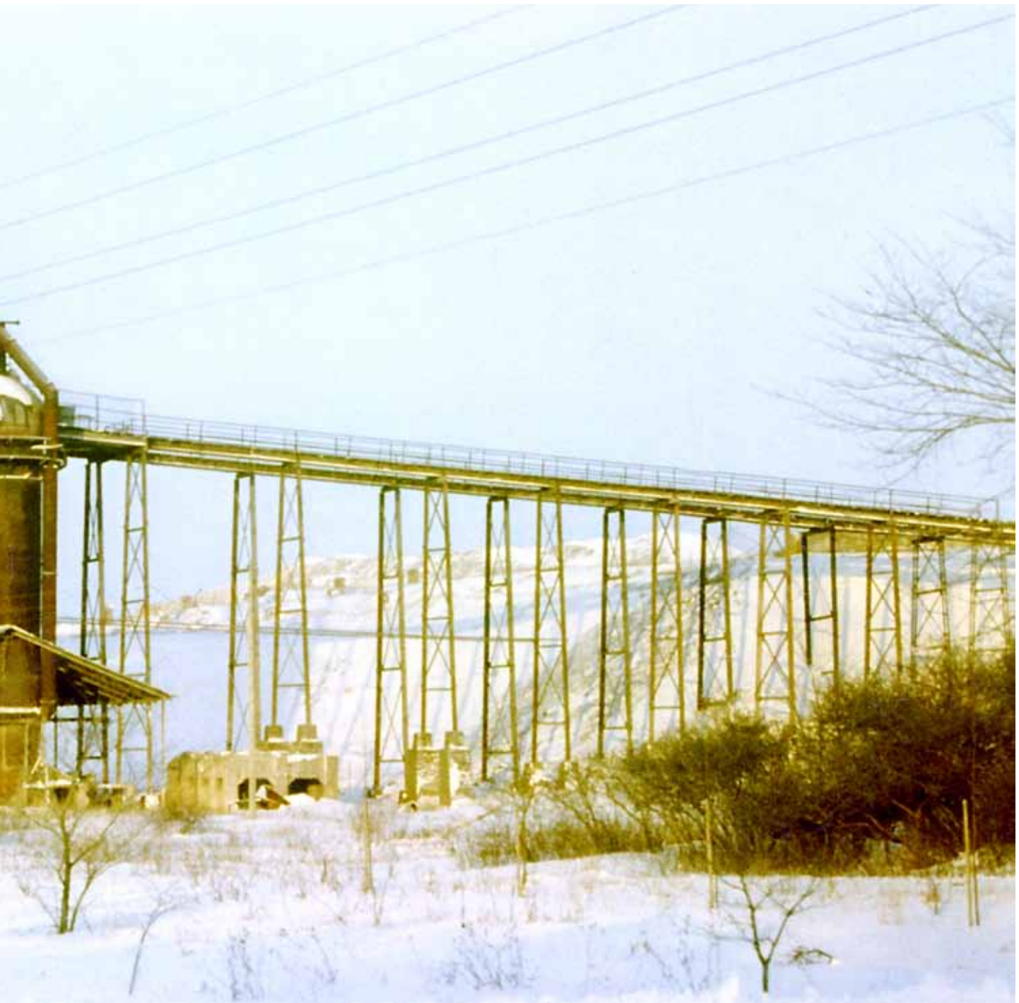
Masugnsanläggningen strax före rivningen år 1960. Bild från Södra Möckleby Hembygdsförening
