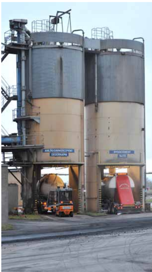
Utlastningen till bulkbil sker från två silor på den norra sidan av cementsilokomplexet. En silo för byggcement och en för anläggningcement. Anläggningen är automatiserad och chaufförerna lastar sina bilar utan assistans från fabriken personal. Foto SOA 2010
