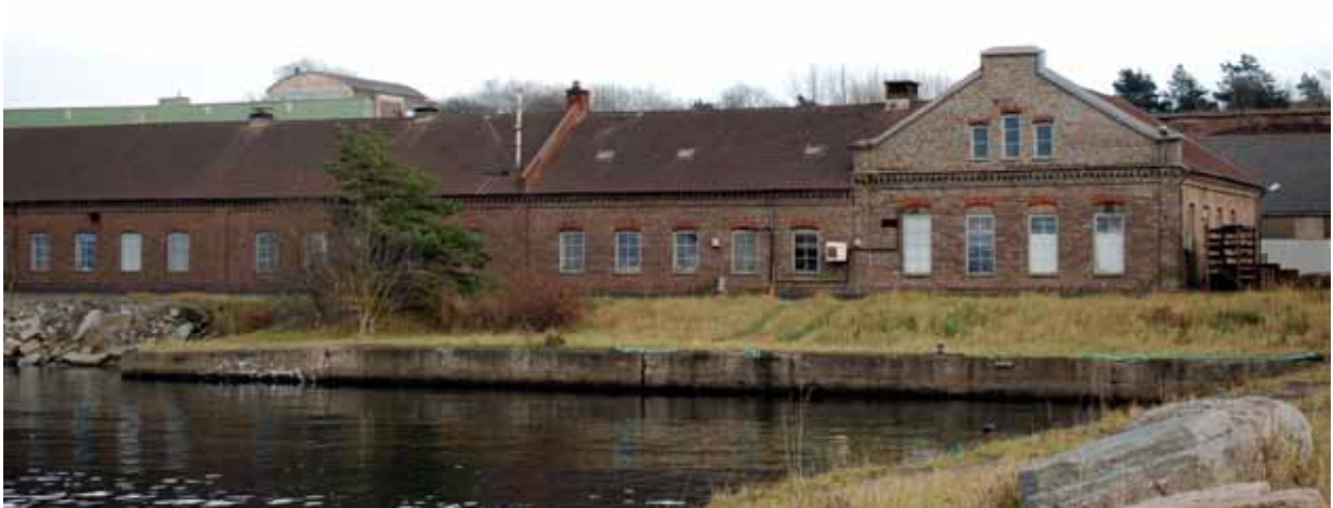
Denna vackra verkstadsbyggnad uppfördes på 1910-talet med fasader murade av kalksten och stickbågiga fönster. Foto LKU 2010
