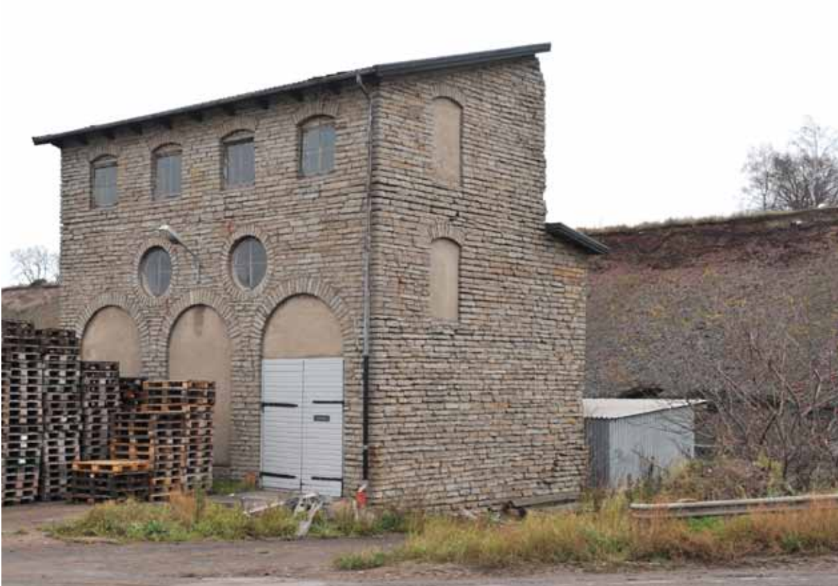
Krosshuset för alunskiffer byggdes år 1917 i samband med den stora satsningen på att använda skiffern som både bränsle i kraftcentralens ångpannor och råvara vid cementtillverkningen. Idag för byggnaden en tynande tillvaro i skuggan av de askdeponier som omger fabriken i öster. Bild SOA 2010
