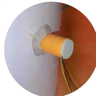
Figur 1. Illustration av skillnaden mellan ett plåtmontage och ett betongmontage. Betongmontaget följer ett standardförfarande enligt RBK-manualen. Vid plåtmontaget appliceras en första tätning mellan plåt och betong och därefter en andra tätning mellan foderrör och plåt.
