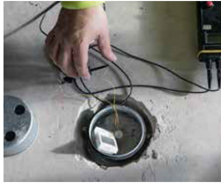
Temperaturlogger monteras och givaren funktionsprovas.
