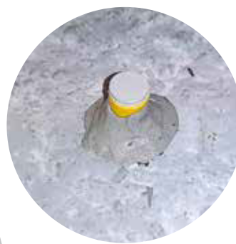
Figur 1. Illustration av skillnaden mellan ett plåtmontage och ett betongmontage. Betongmontaget följer ett standardförfarande enligt RBK-manualen. Vid plåtmontaget appliceras en första tätning mellan plåt och betong och därefter en andra tätning mellan foderrör och plåt.
